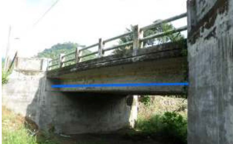
Fotografía 21.1- 43 Puente quebrada Boquerón
