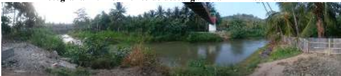
Fotografía 21.1- 39 Punto de descarga de la PTAR San Gabriel
